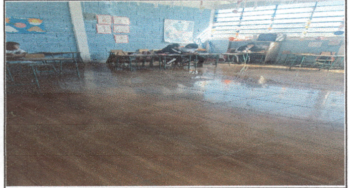
Foto 2: Piso ceramico terminado al cien por ciento
