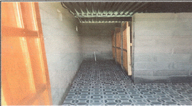
Foto 3: Sanitarios terminado al cien por ciento
